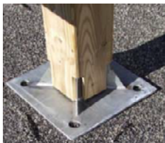
Détail platine de portique
